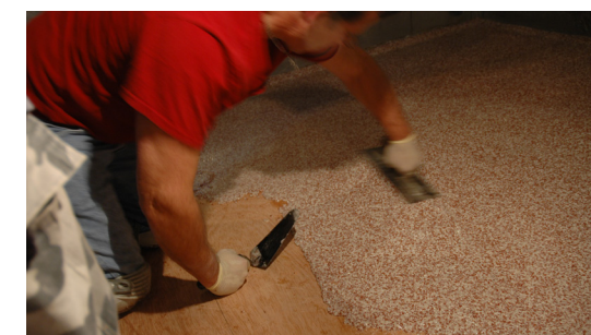
나무바닥 바로 시공
