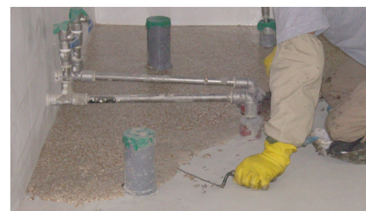
콘크리트 바로 시공
