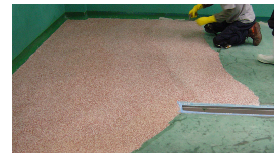
에폭시 바로 시공
