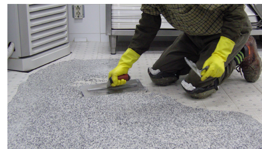
타일, 테라조 바로 시공
